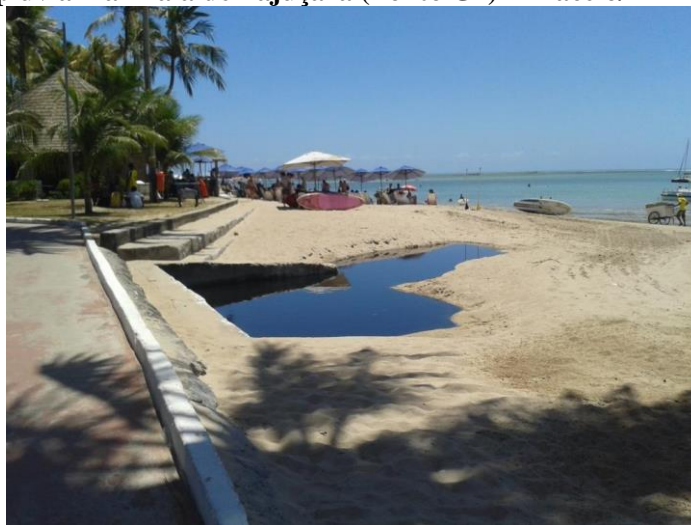
Figura 3 – Galeria pluvial na Praia de Pajuçara (Ponto G7) – Maceió/AL
