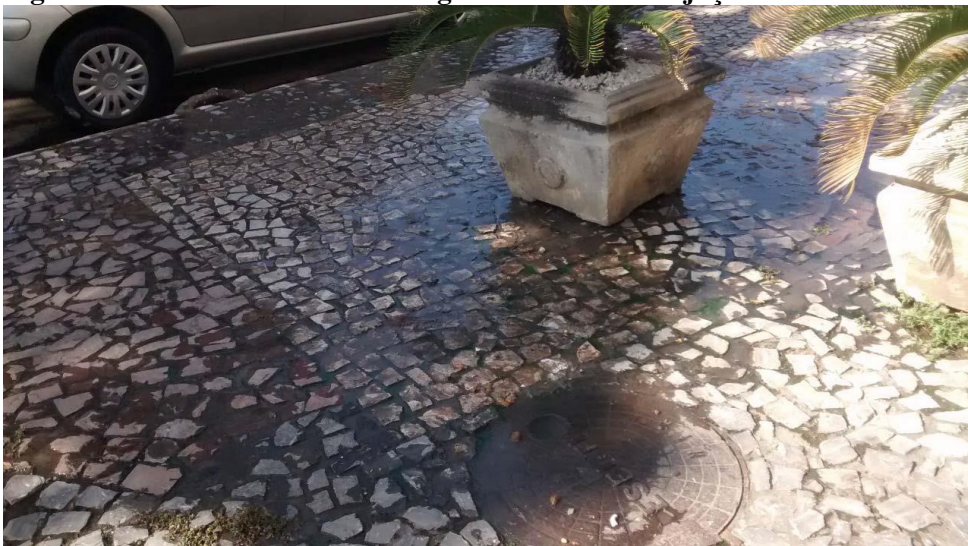
Figura 9 – Transbordamento de esgoto na Bacia da Pajuçara.
