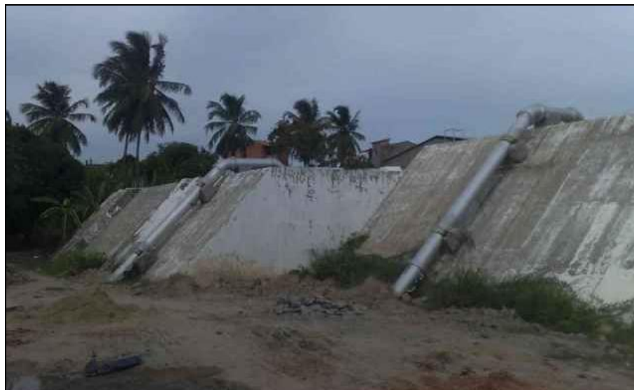
Figura 31 – Reservatório apoiado R-1. Fonte: CASAL (2010).
