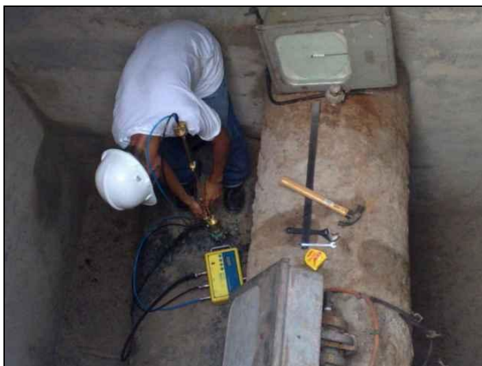
Figura 37 – Colaborador da Enops Engenharia instalando tubo pitot. Fonte: CASAL (2010).
