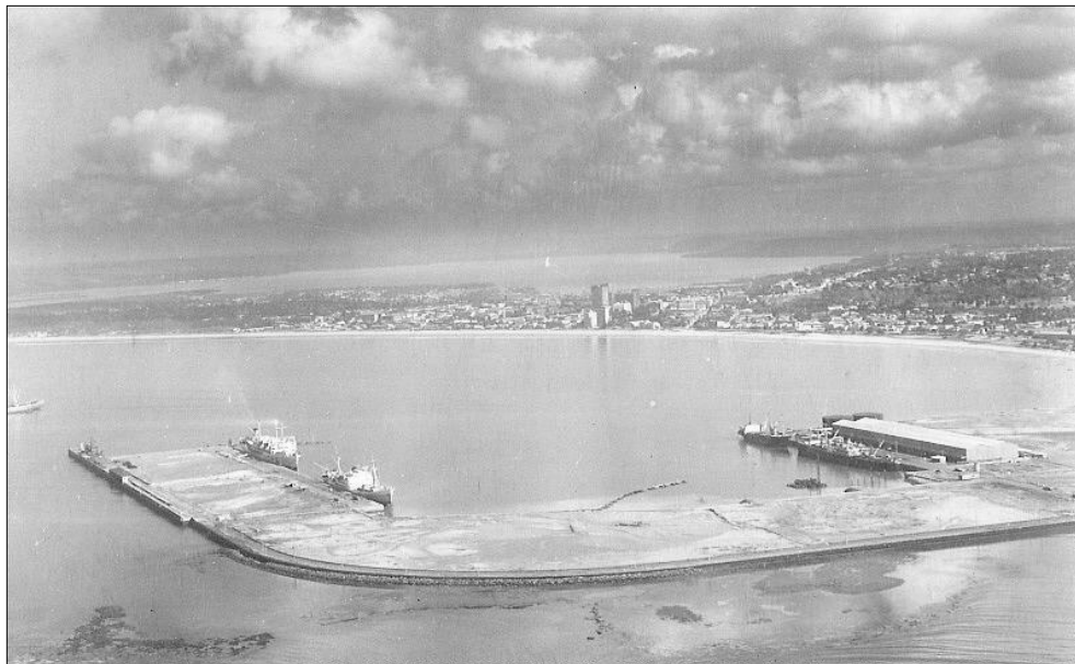
Figura 7 – Vista aérea do porto de Jaraguá
