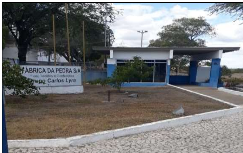
Figura 6 – Frente da Fábrica da Pedra
