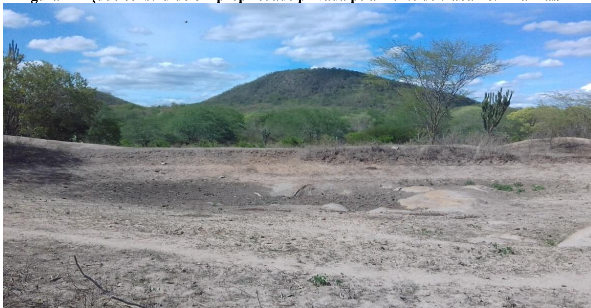
Figura 2- Açude construído em propriedade privada pela frente de trabalho. Piranhas/AL
