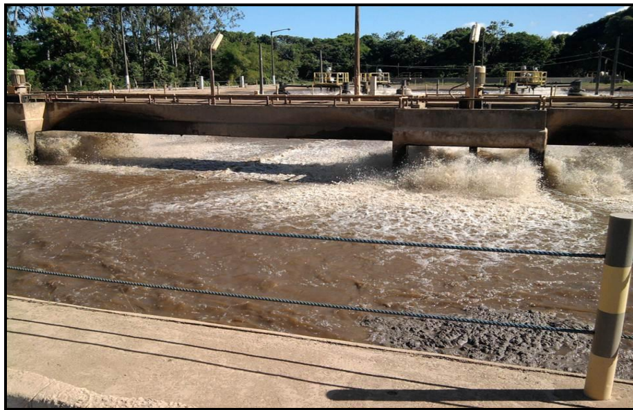
Figura 7 - Estação de tratamento da CINAL
