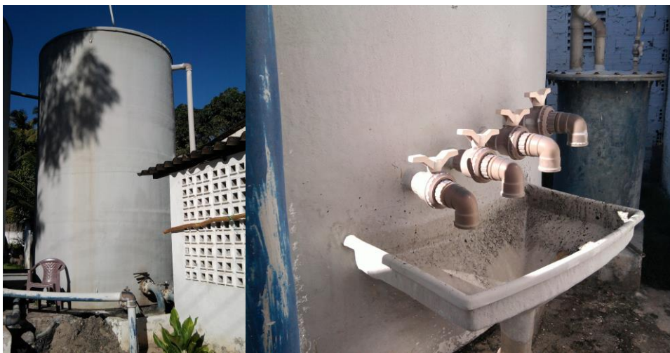
Figura 13 - Reator UASB da cidade de São Miguel- AL.
