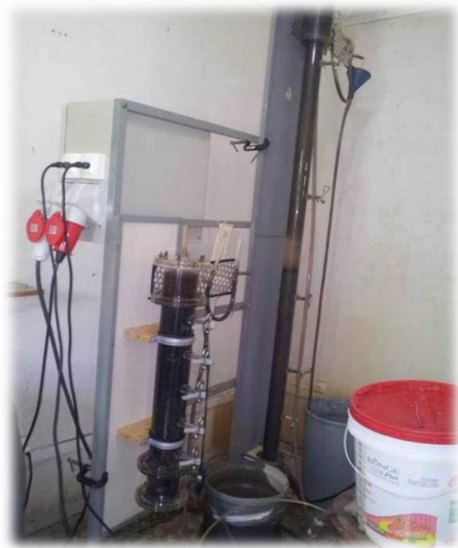
Figura 9 - Reatores anaeróbios usados no sistema.
