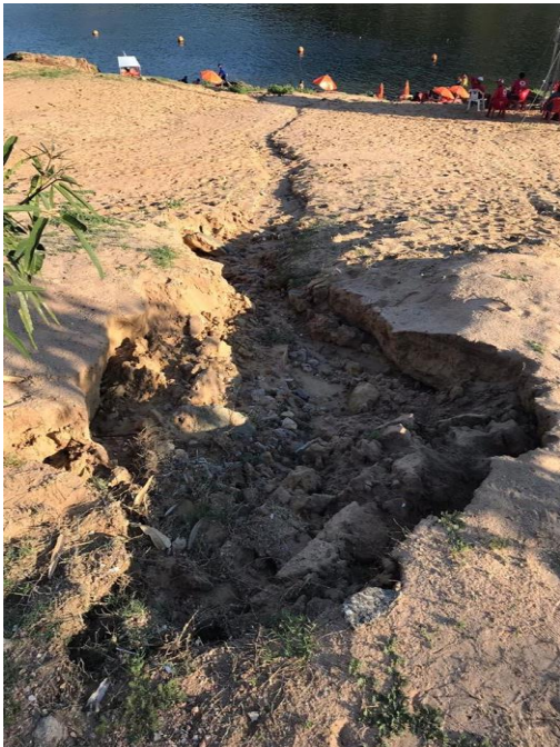
Figura 10. Erosão do solo
