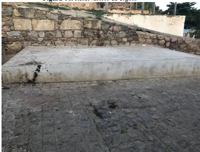
Figura 06. Reservatório de esgoto
