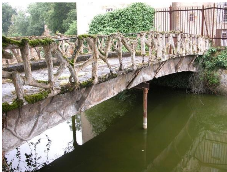
Figura 1: Primeira ponte de concreto armado do mundo, construída na França em 1875.
