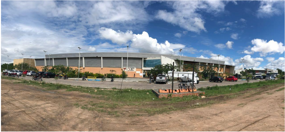
Figura 16: Campus Sertão, fachada principal.
