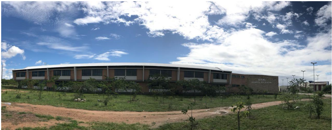
Figura 17: Fachada que pode ser vista por quem passa pela AL 145.
