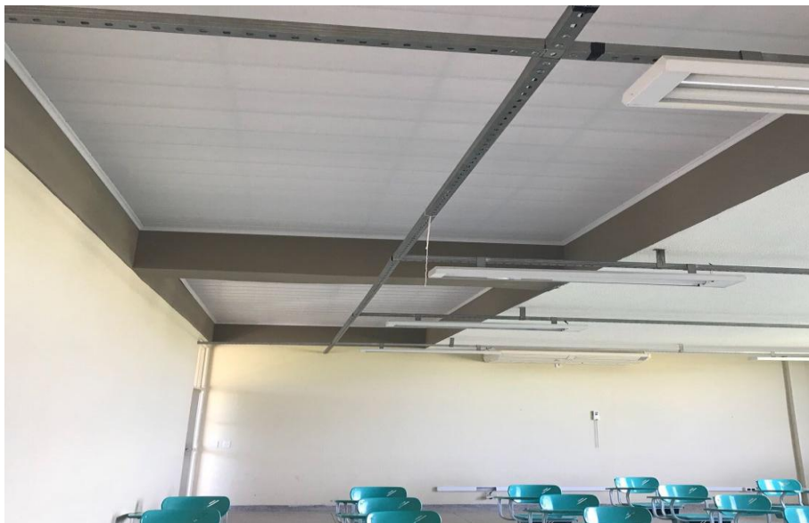
Figura 10: Aberturas dos sheds fechadas com forro de PVC.
