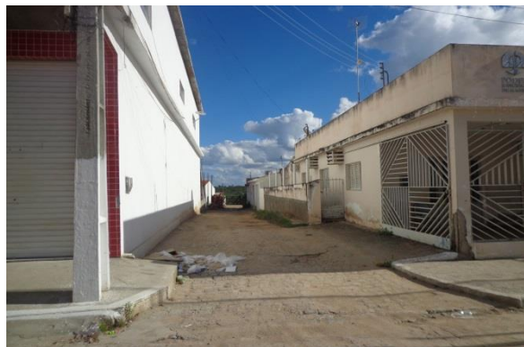
f) Rua estreita, sem calçada
