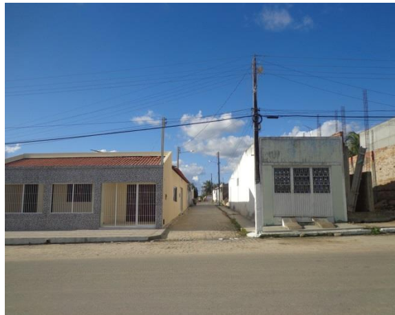
b) Edificação usando o espaço da calçada
