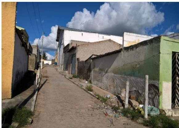
g) Falta de manutenção
