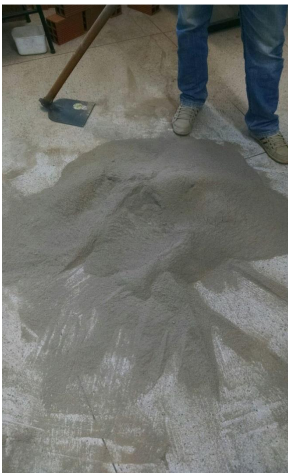
Figura 31: Materiais já homogeneizados, prontos para receberem água.
