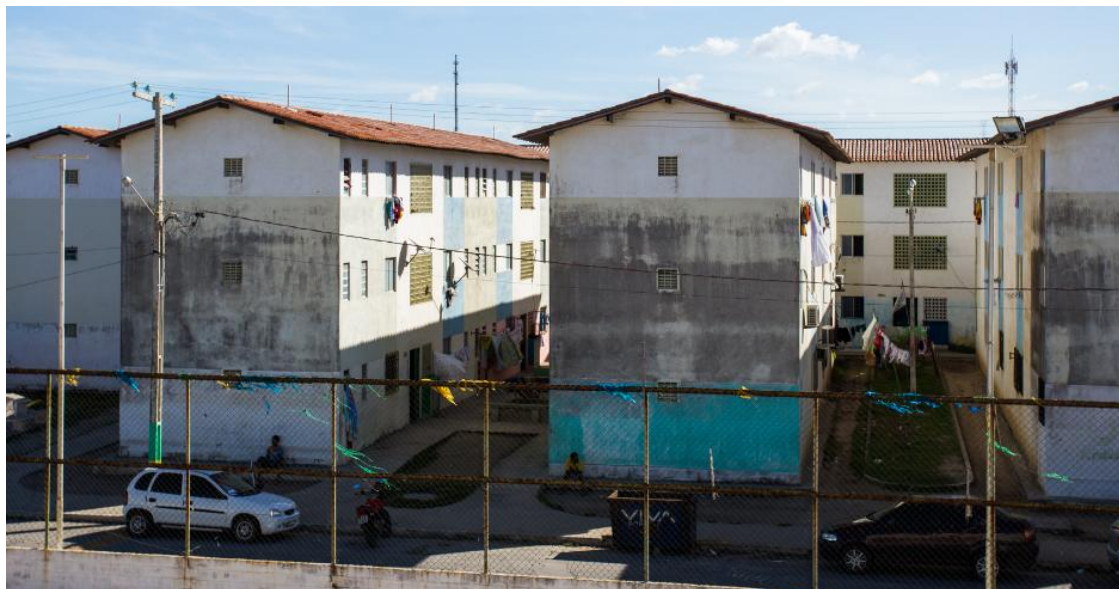
Figura 82 - Condomínio Vila dos Pescadores, na praia do Sobral
