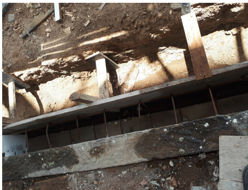
Figura 17 – Trecho da viga baldrame concretada na segunda análise
