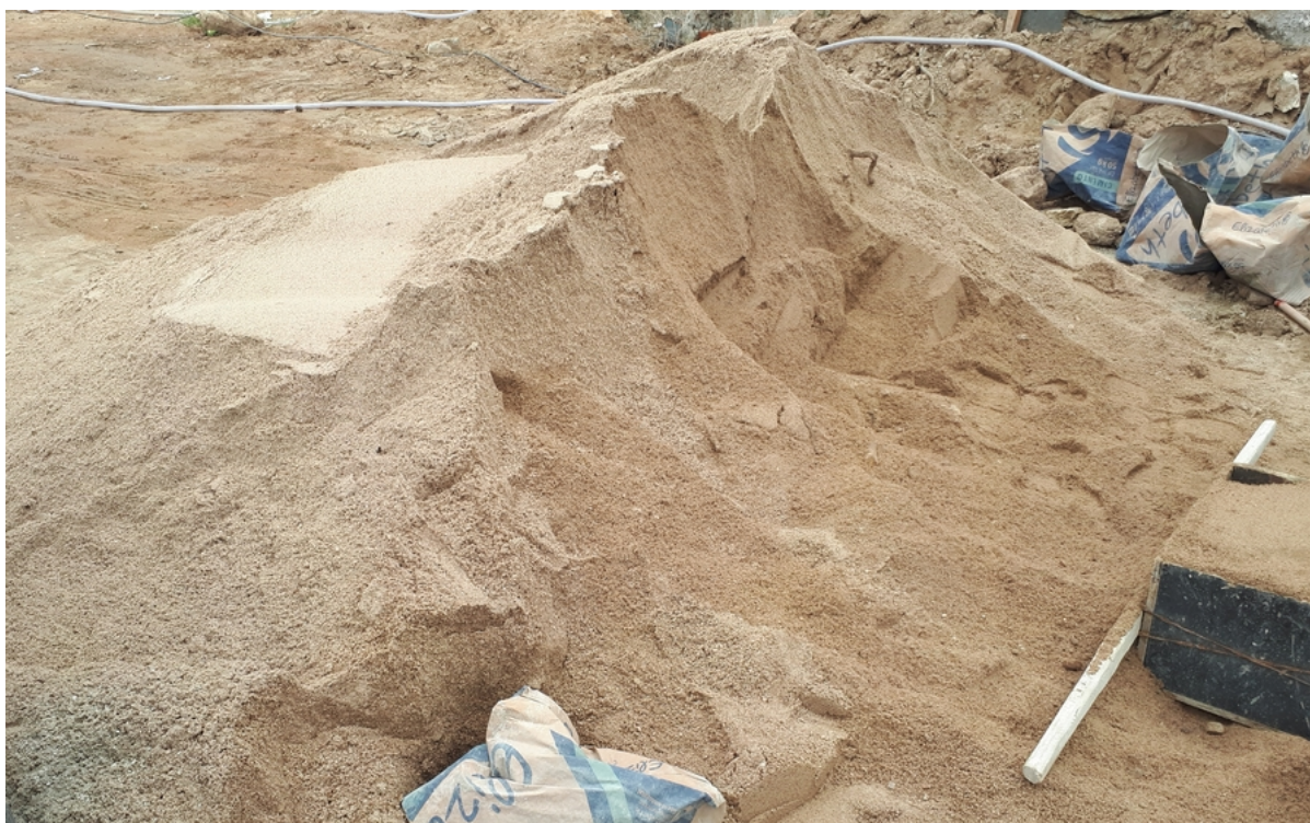
Figura 15 – Volume final de areia, a cubagem indicou volume aproximado de 3,5 m 3
