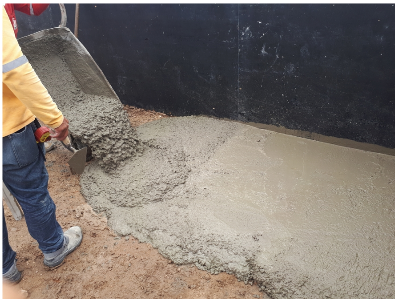
Figura 8 – Lançamento do concreto no ponto de concretagem
