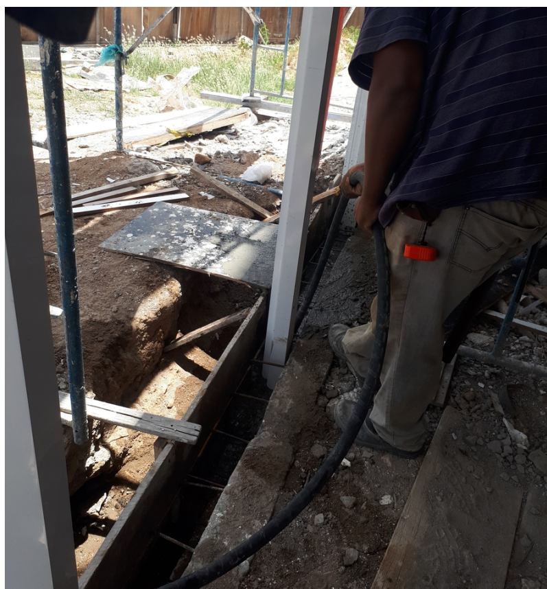
Figura 21 – Adensamento do concreto estrutural
