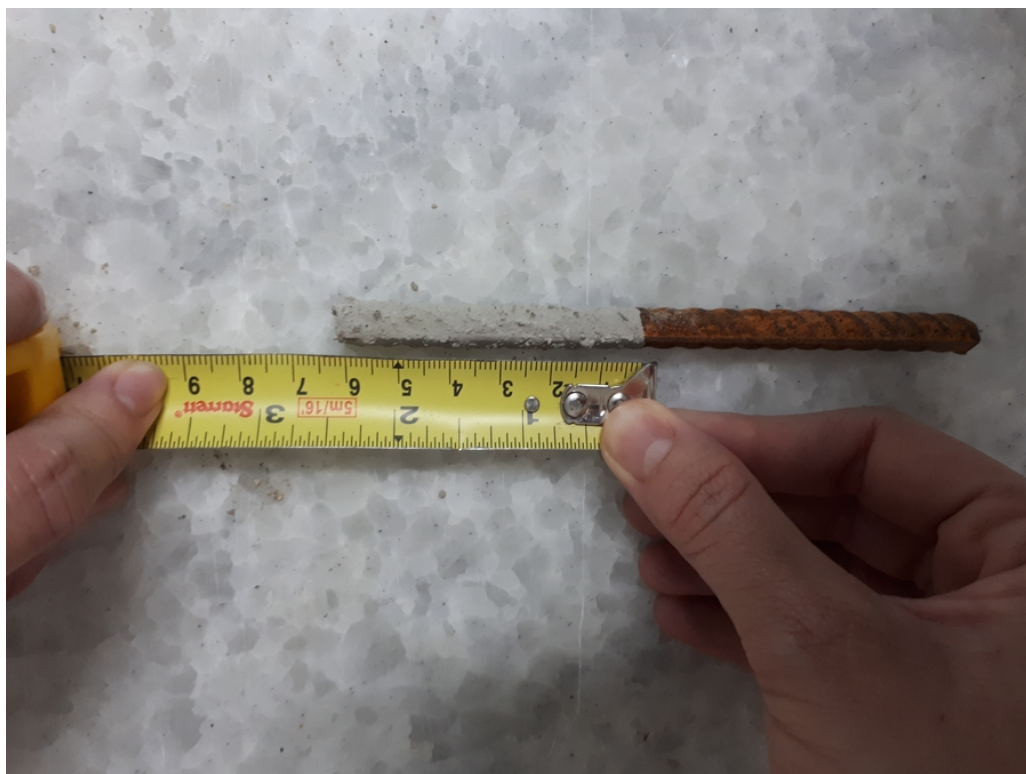
Figura 11 – Segunda profundidade de concreto (6 cm)
