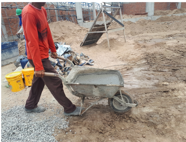
Figura 20 – Transporte do concreto recém-preparado
