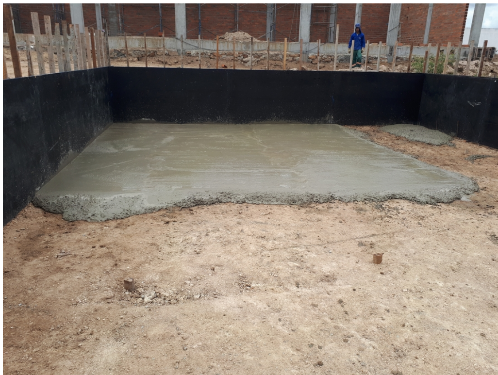
Figura 9 – Área concretada pelos dez traços (3,45 x 3,90 metros)
