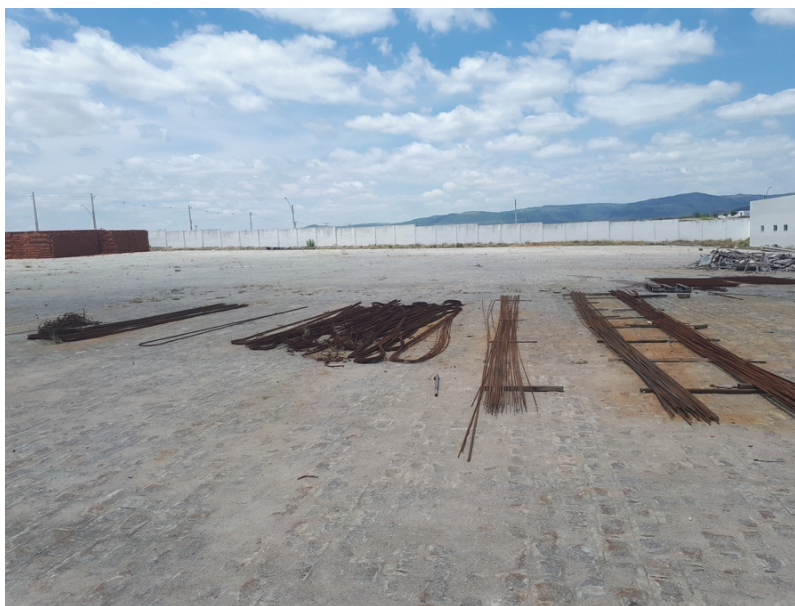
Figura 25 – Estoque final de aço, após o preparo da armação da viga baldrame
