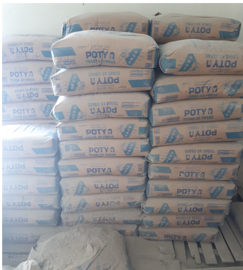
Figura 33 – Pilhas de 10 sacos de cimento sobre estrados de madeira
