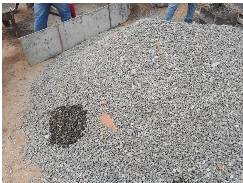
Figura 32 – Quantidades grandes de impurezas em meio aos agregados
