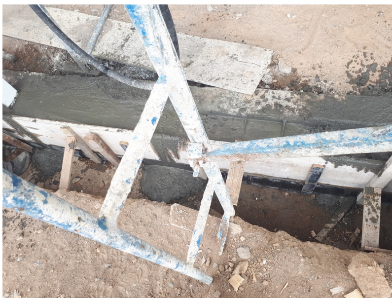
Figura 35 – Diversos pontos em que o concreto não foi lançado dentro da fôrma
