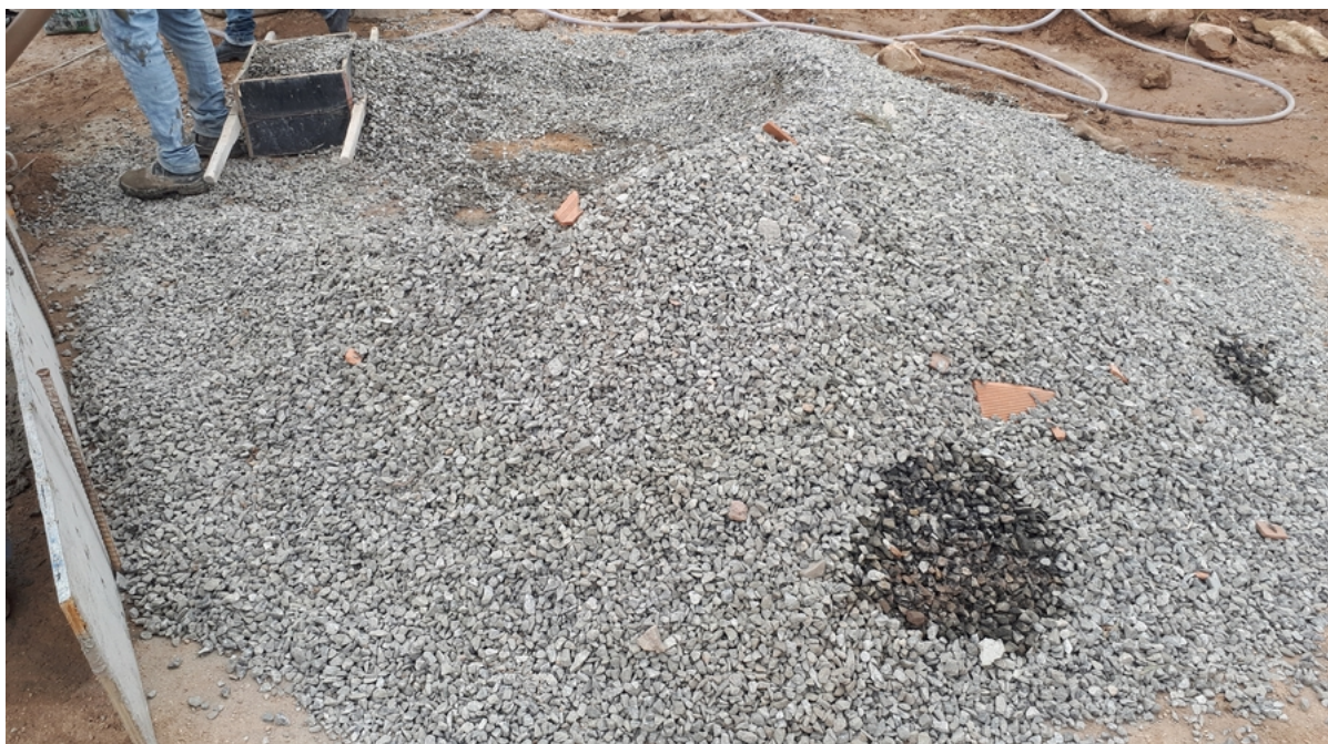
Figura 16 – Volume final de brita, a cubagem indicou um volume aproximado de 2 m 3
