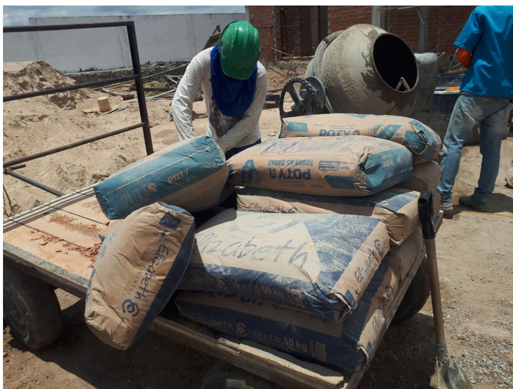
Figura 18 – Carrinhos utilizados no transporte do cimento
