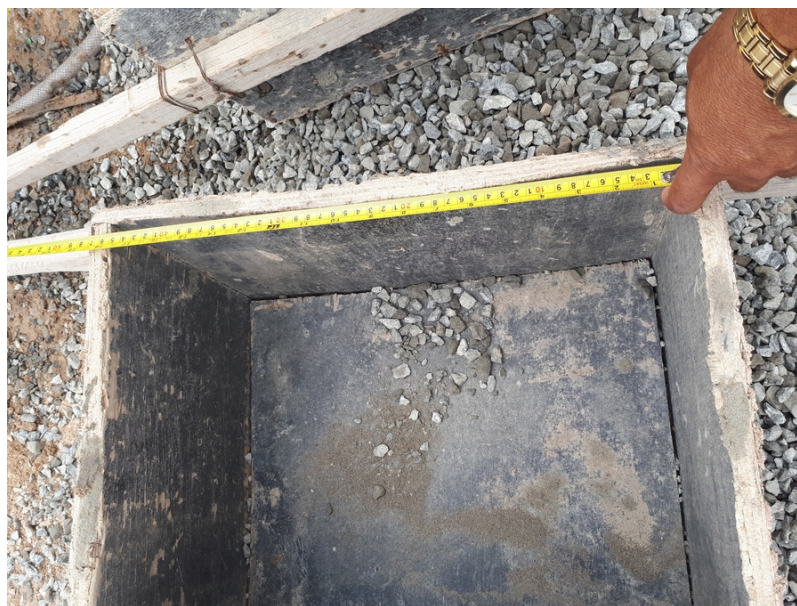
Figura 5 – Verificação das medidas internas das padiolas utilizadas
