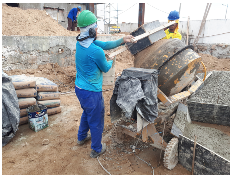
Figura 7 – Colocação dos agregados na betoneira com o uso das padiolas
