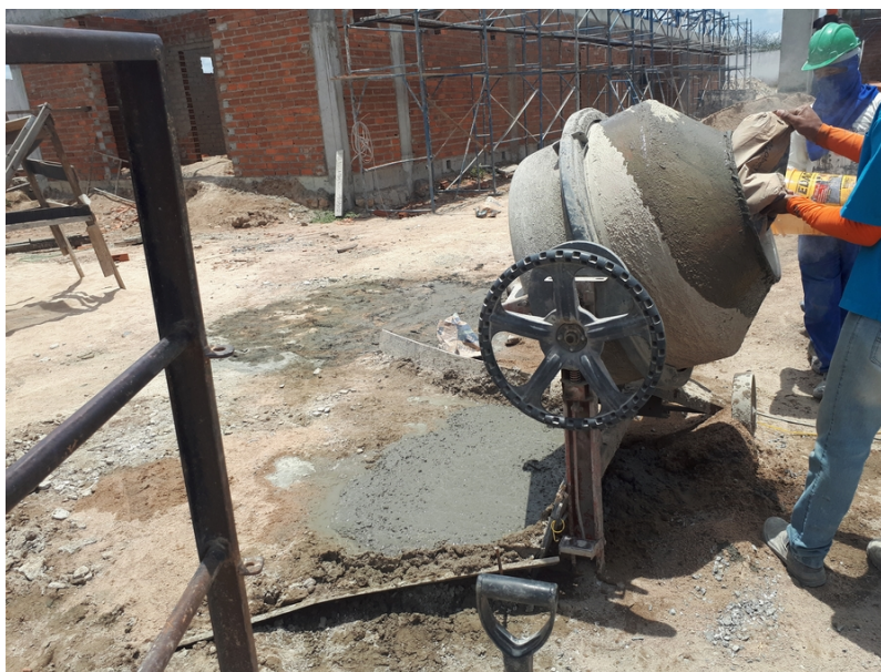
Figura 19 – Processo de inserção de cimento na betoneira
