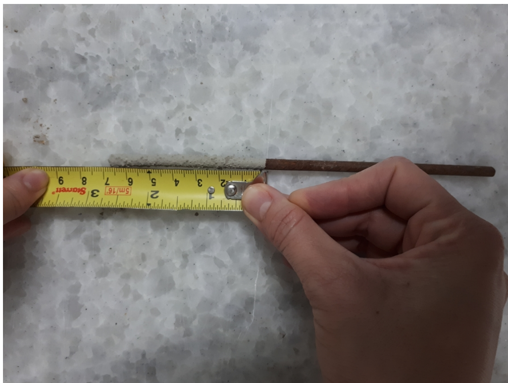
Figura 12 – Terceira profundidade de concreto (6,5 cm)
