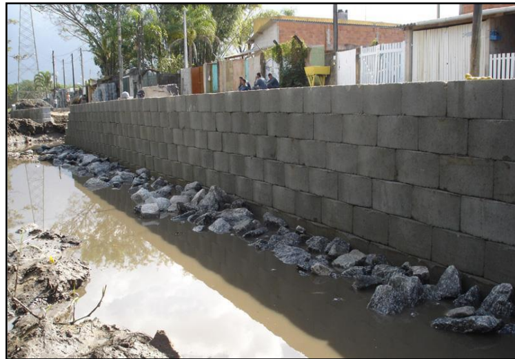
Figura 02: Construção de muro com blocos segmentais. Fonte: www.fixsolo.com.br .
