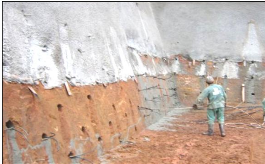
Figura 05: Estabilização de encosta com a técnica de grampeamento do solo. Fonte: www.solotrat.com.br
