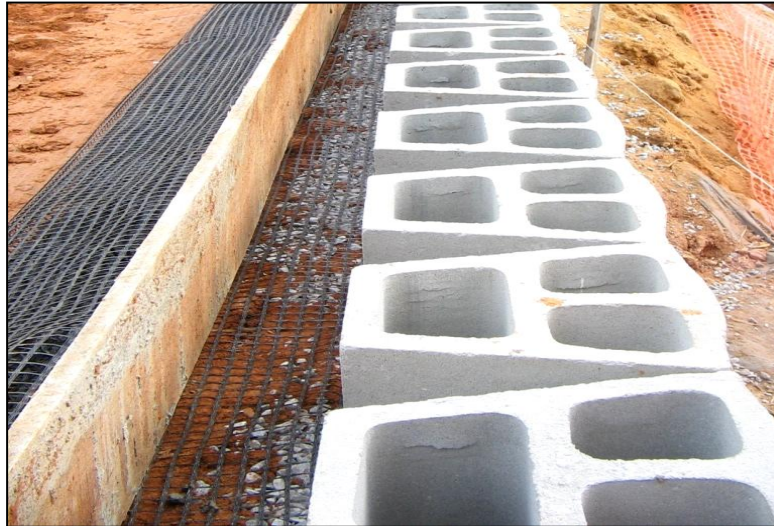
Figura 34: Geogrelhas e blocos de concreto na espera do dreno de brita. Fonte: www.agrogeo.com
