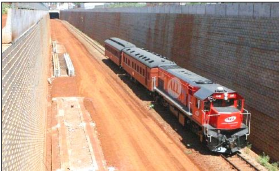
Figura 25: Obra do rebaixamento da linha férrea na cidade de Maringá - PR (SILVA e BRUGGER, 2012).
