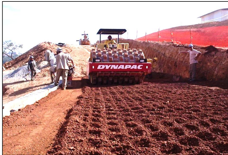
Figura 35: Compactação com soquete vibratório e com rolo compactador. Fonte: www.agrogeo.com
