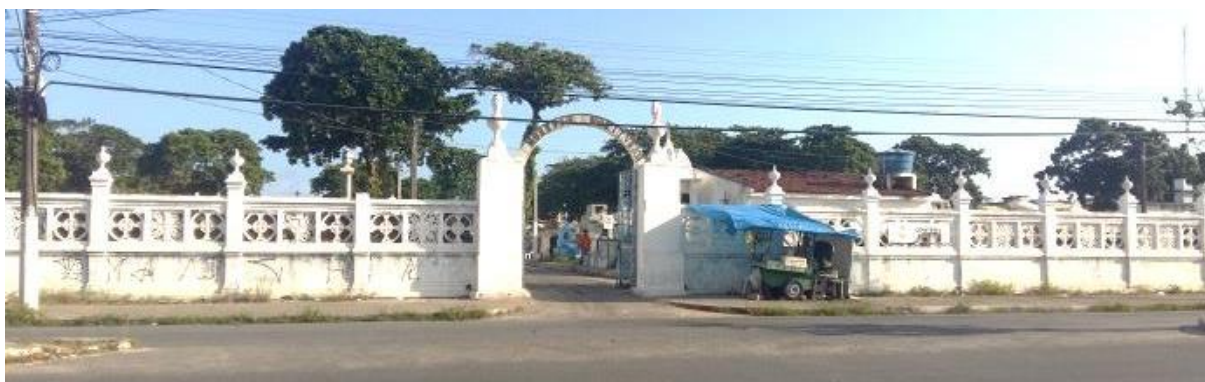
Figura 12 – Fachada principal do cemitério São José no Prado. Fonte: Acervo pessoal, 2017.
