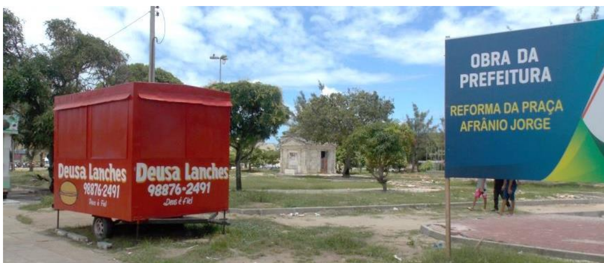
Figura 32 – Registro da Praça da Faculdade em processo de reforma. Panteão ao fundo já dado início à vedação da entrada com alvenaria. Fonte: Acervo pessoal, 2016.
