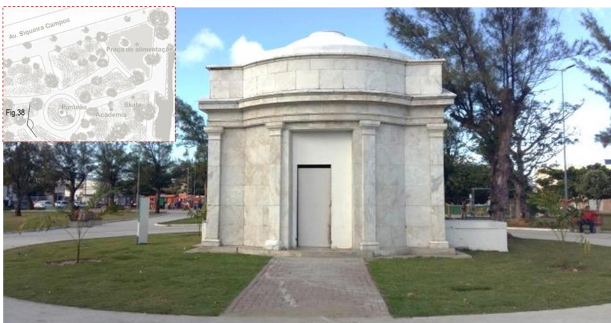
Figura 38 – Foto da fachada de entrada do Panteão, oposta à da Figura 37, após a revitalização em 2016. Observa-se o bloqueio da entrada com alvenaria e a instalação de modo improvisado da porta de madeira. Ao canto superior esquerdo recorte do croqui geral da Praça com indicação do ângulo de captura da fotografia. Fonte: Acervo pessoal, 2016. Base cartográfica da Prefeitura de Maceió. Trabalhado pela autora.
