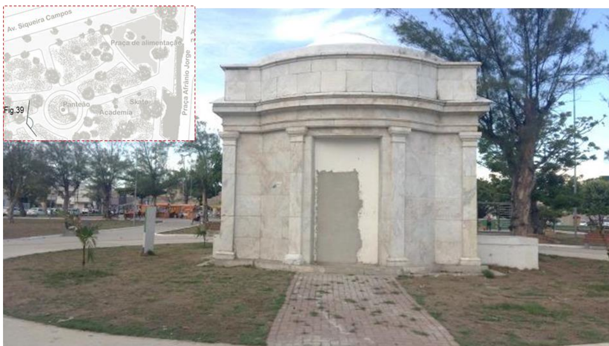
Figura 39 – Foto da fachada de entrada do Panteão, oposta à da Figura 37, após a revitalização em 2016. Observa-se o bloqueio da entrada com alvenaria e o complemento do bloqueio substituindo a porta de madeira. Fonte: Ao canto superior direito recorte do croqui geral da Praça com indicação do ângulo de captura da fotografia. Fonte: Acervo pessoal, 2017. Base cartográfica da Prefeitura de Maceió. Trabalhado pela autora.
