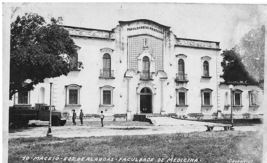
Figura 18 – Fotografia da fachada do prédio do antigo Quartel, reformado para abrigar a Faculdade de Medicina de Alagoas. Fonte: Acervo digital do Museu de Imagem e Som de Alagoas – MISA, s/d.
