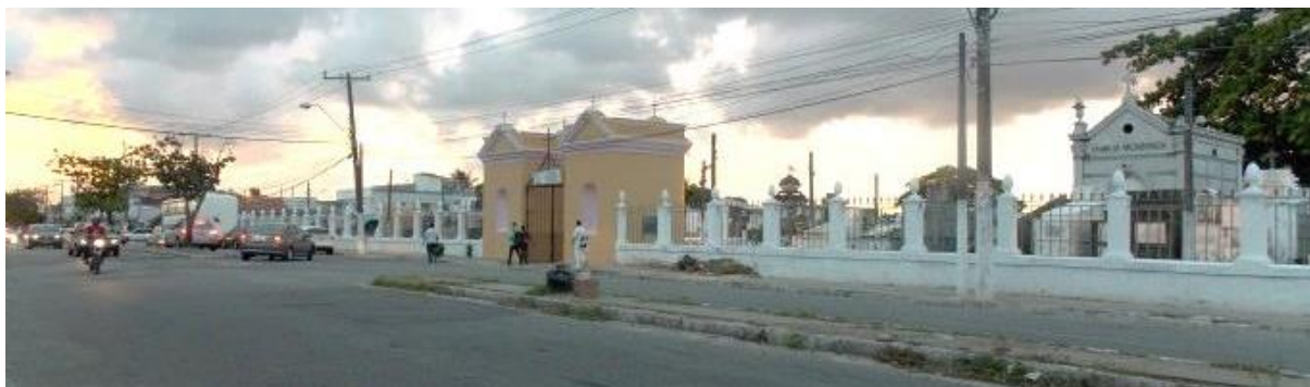
Figura 13 – Fachada principal do cemitério Nossa Senhora da Piedade no Prado e Avenida Siqueira Campos. Fonte: Acervo pessoal, 2017.
