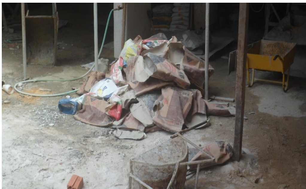
Figura 8 - Saco de cimento em local inadequado
