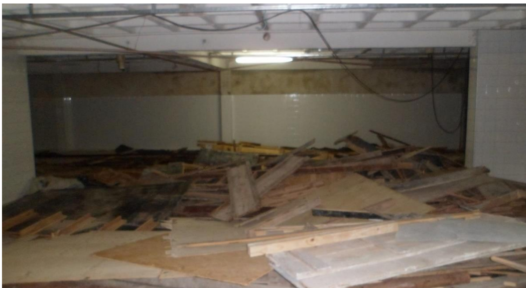
Figura 14 - Ausência na ATT
