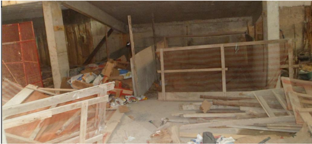
Figura 19 - Instalação de baias no subsolo
