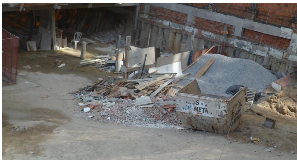
Figura 10 - Resíduos despejados em local inadequado
