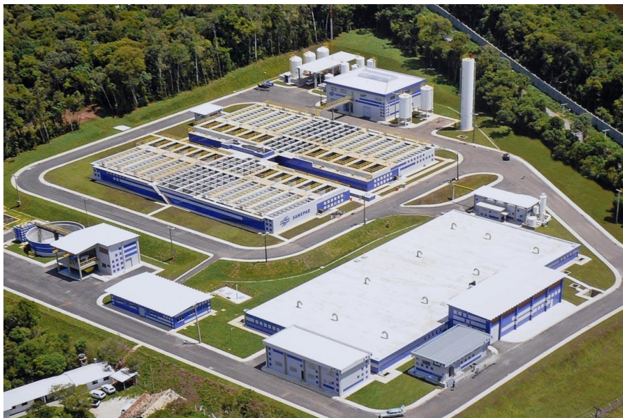
Figura 11 – Estação de tratamento de água Miringuava – São José dos Pinhais, Paraná.
