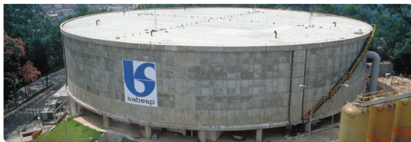
Figura 12 – Reservatório de água tratada da Sabesp.
