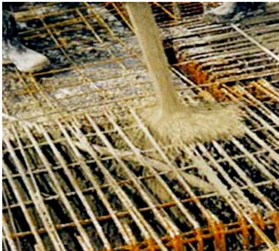
Figura 1 - Lançamento de CF em estrutura densamente armada.
