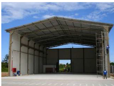
Figura 03: Estrutura que deve ser utilizada como galpão de reciclagem
