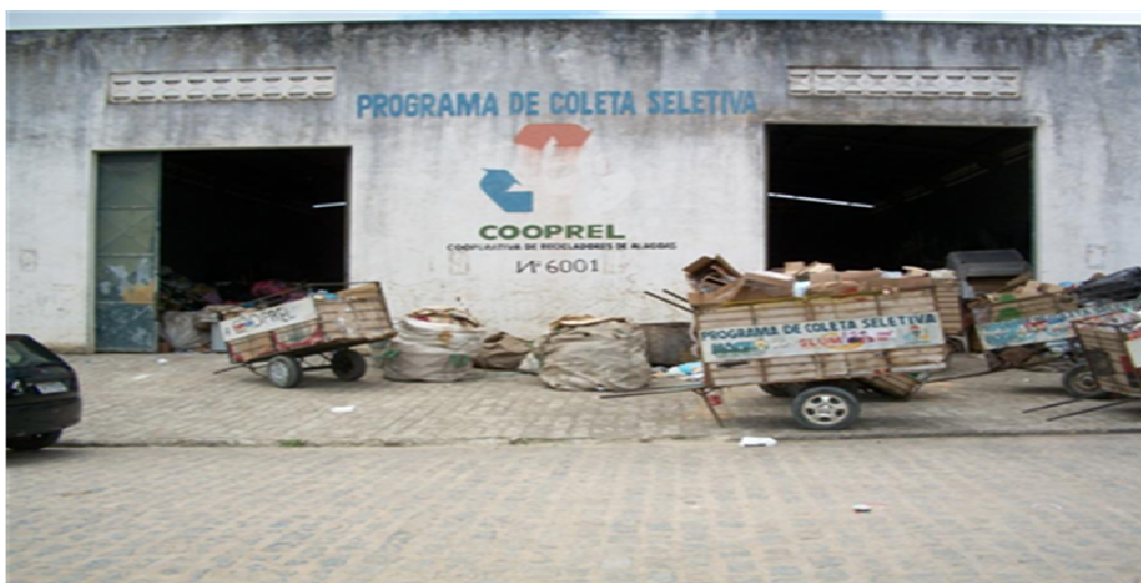
Figura 02: Vista de Frente do Galpão da COOPREL.
