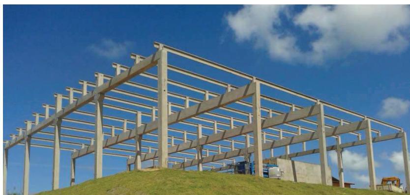
Figura 11: Galpão com a tipologia de ligação mostrado na Figura 10.
