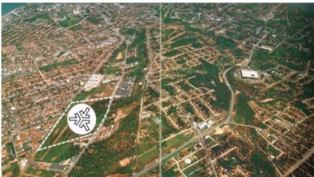
FIGURA 33 - Localização do terreno antes da construção do Maceió Shopping em 1988
