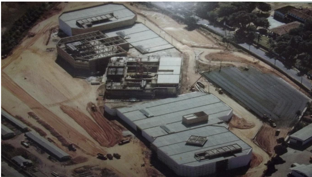
FIGURA 34 - Imagem aérea durante a construção do Maceió Shopping em 1988
