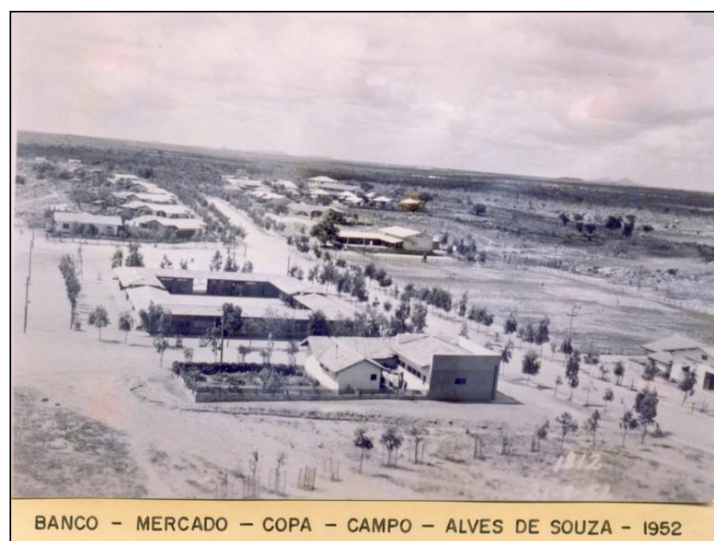
Fotografia 12: Obras do acampamento da CHESF.
