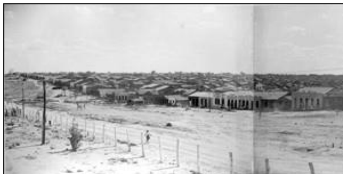
Fotografia 8: Divisão do arame farpado que dividia o acampamento CHESF, de 1948
