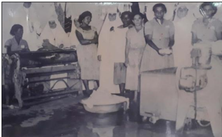
Fotografia 33: Máquinas industriais da lavanderia do HNAS.
