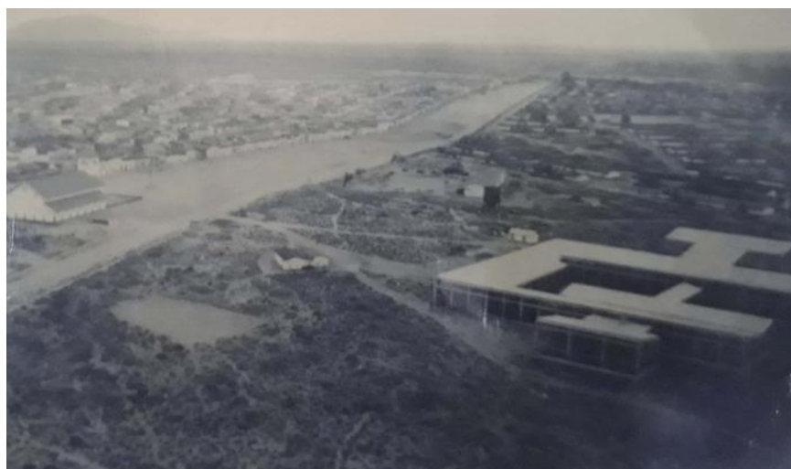
Fotografia 17: Vista aérea do prédio em construção do Hospital Estadual
