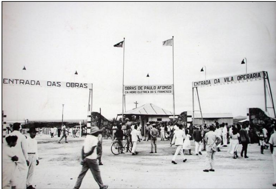
Fotografia 11: Início das obras do acampamento de Paulo Afonso.
