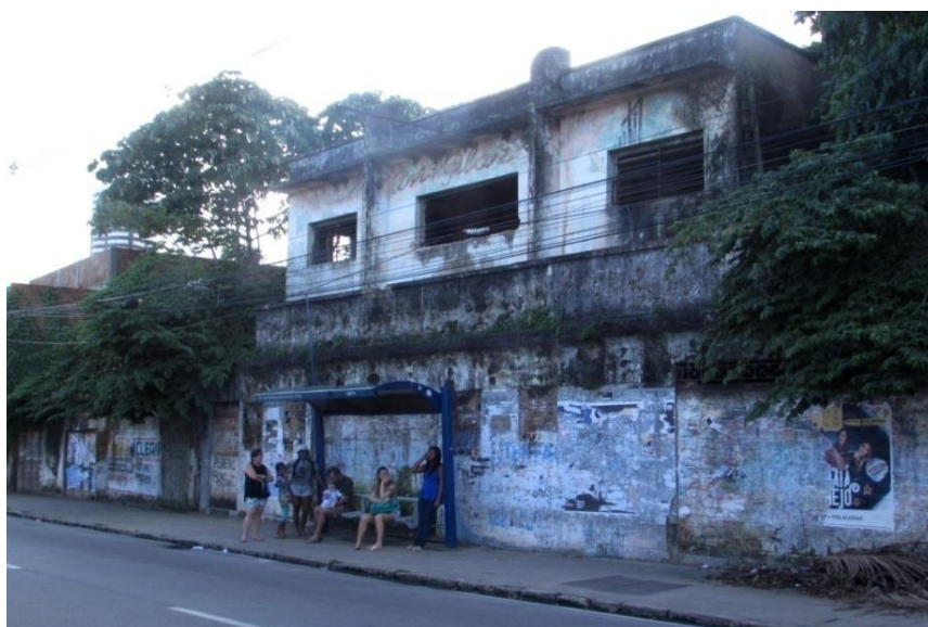
Figura 27 – Prédio onde funcionou o Cine Plaza
