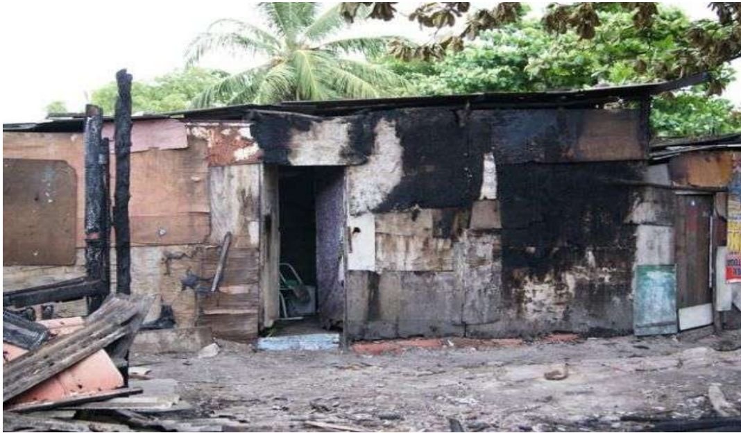
Imagem 31: Barraco após curto-circuito-Favela Sururu de Capote
