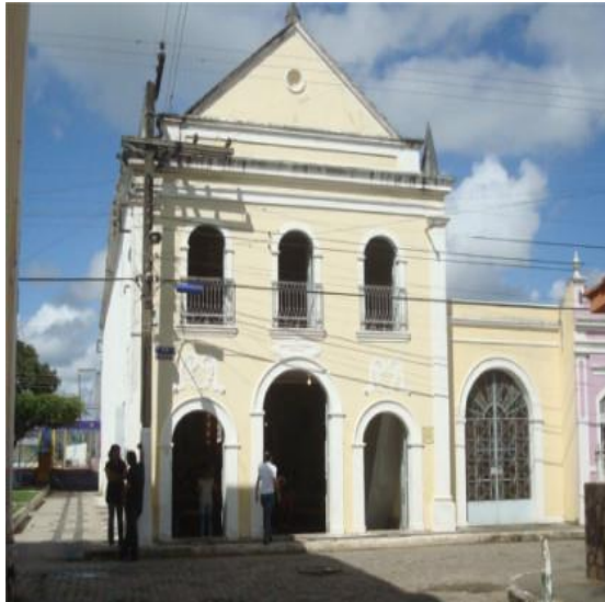
Figura 35: Igreja Santa Cruz do Cortume, época atual. Fonte: Site Oficial do SIPEAL/Penedo – Acesso: 04/07/2017
