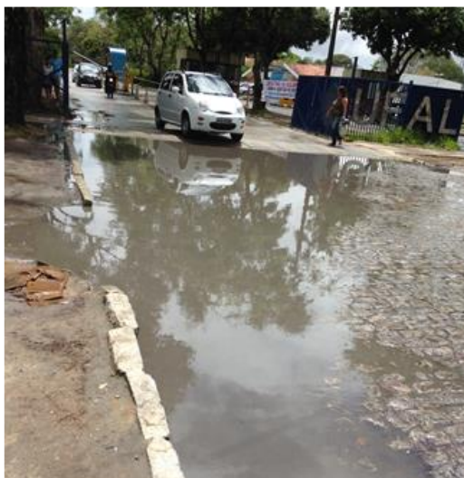
Figura 19 - Imagem da entrada principal da UFAL em um dia de chuva, com acúmulo de água na sarjeta.
