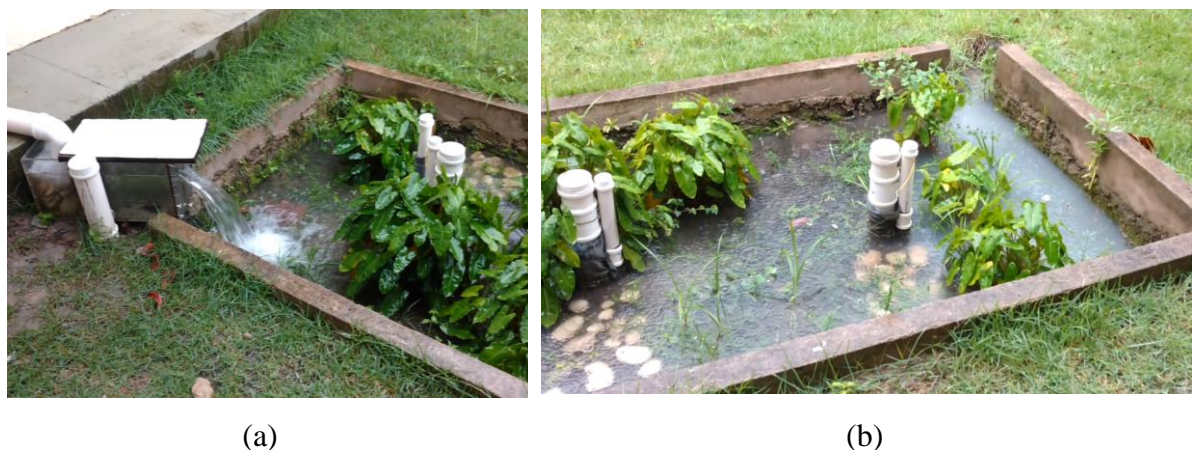
Figura 24 – Presença de nível d'água acima da camada superior da biorretenção, no evento de 02 de junho de 2016: a) contribuição do telhado; b) contribuição do terreno.
