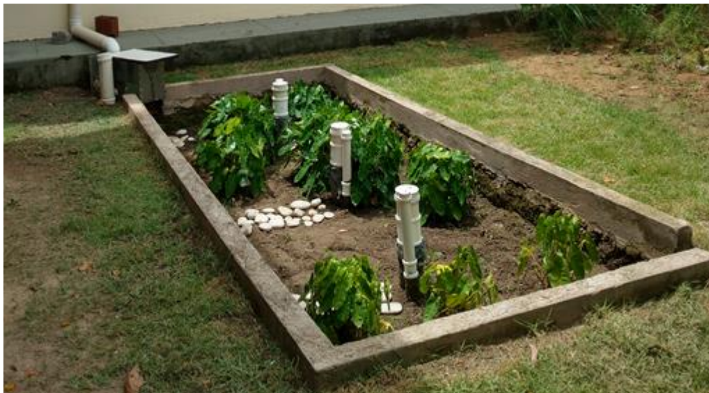
Figura 9 - Imagem da biorretenção em 2016.
