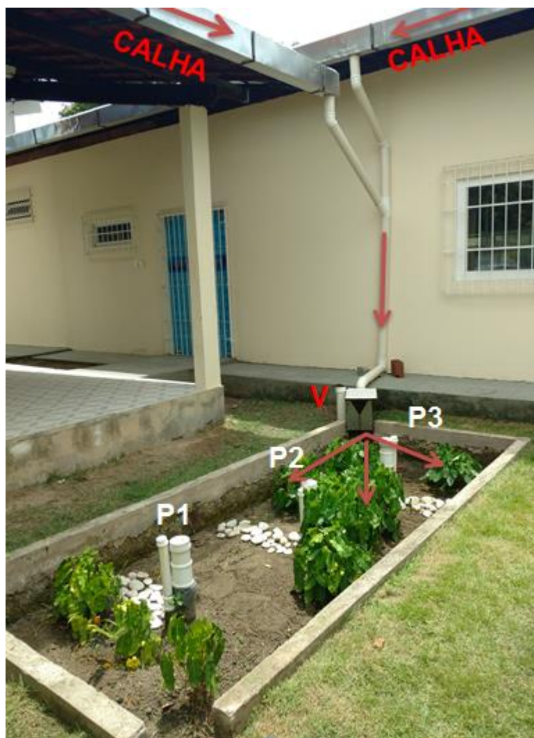
Figura 17 - Esquema de lançamento e monitoramento da biorretenção.
