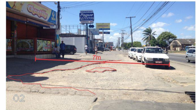
Calçadas irregulares, revestimentos disformes, trepidantes e derrapantes, deteriorados em alguns pontos
