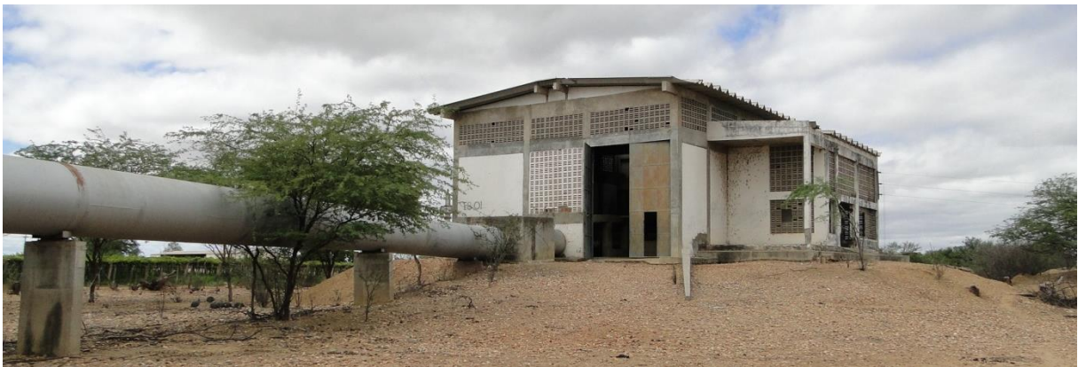
Ilustração 4: Fotografia da Antiga casa de bomba e adutora da Fazenda Catalunha.
