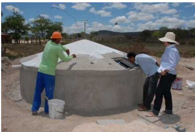
Figura A.6: Construção de cisterna em fase final
