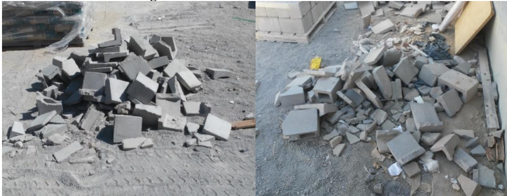
Figura 8 - Resíduo de blocos de concreto.
