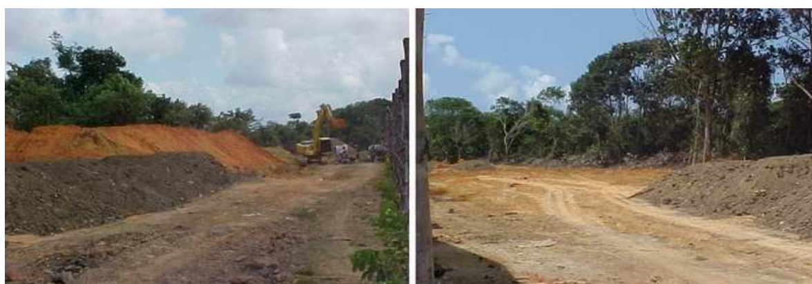
Figura 10 — Derrubada de árvores para colocação de tubos de drenagem das águas do bairro Santos Dumont, área localizada dentro da APA. A – escavação. B – área aberta. (Foto: Maria das Vitórias julho/2005)
