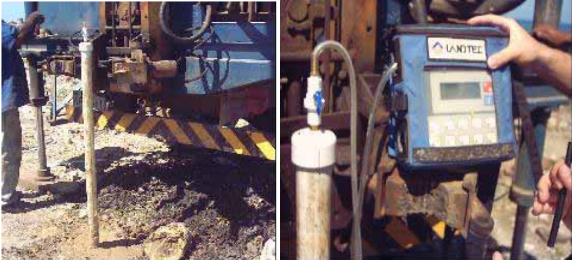
Figura 22 – Perfuração dos poços pilotos no vazadouro a céu aberto de Cruz das Almas. (GESRAD, 2004).
