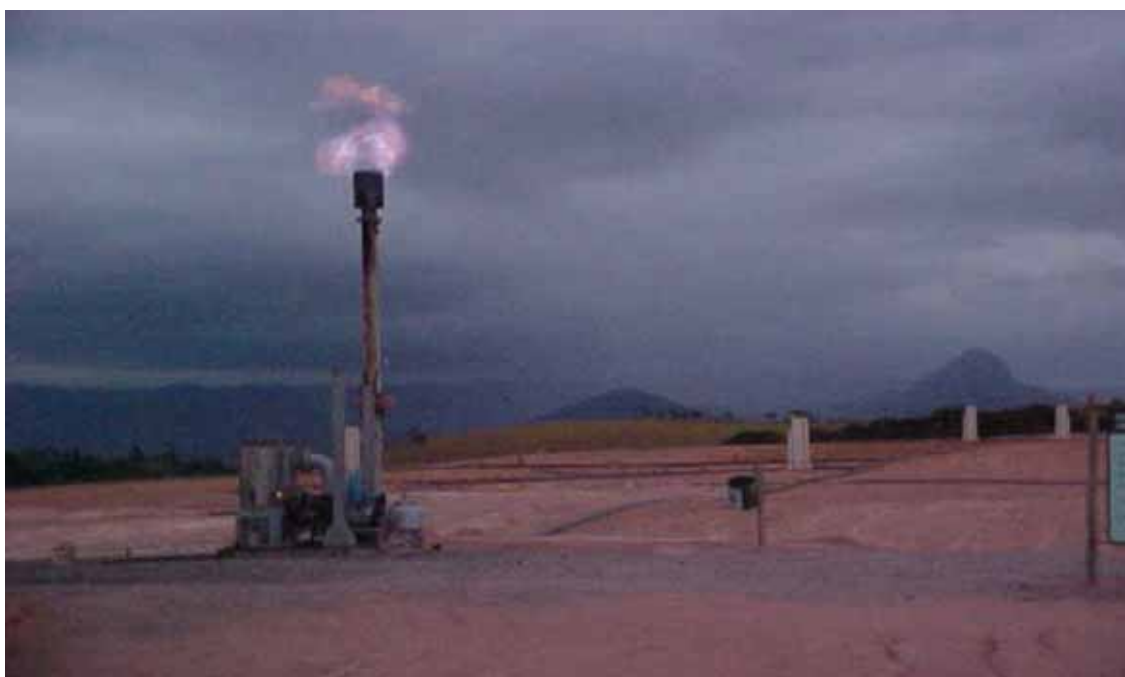
Figura 16 – Queima do Biogás através do flare (GOOGLE, 2009).
