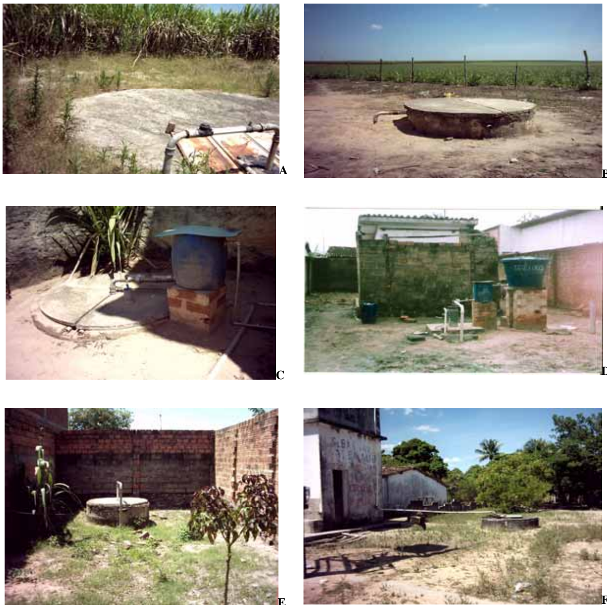
Figura 4: Mananciais subterrâneos (poços) utilizados para captação de água pelo Sistema Autônomo de Água e Esgoto (SAAE), no município de Atalaia,AL. Poços: Branca I (A), Branca II (B), Vila José Paulino (C), Rua de Cima (D), Loteamento Santa Inês (E), Boca da Mata (F).
