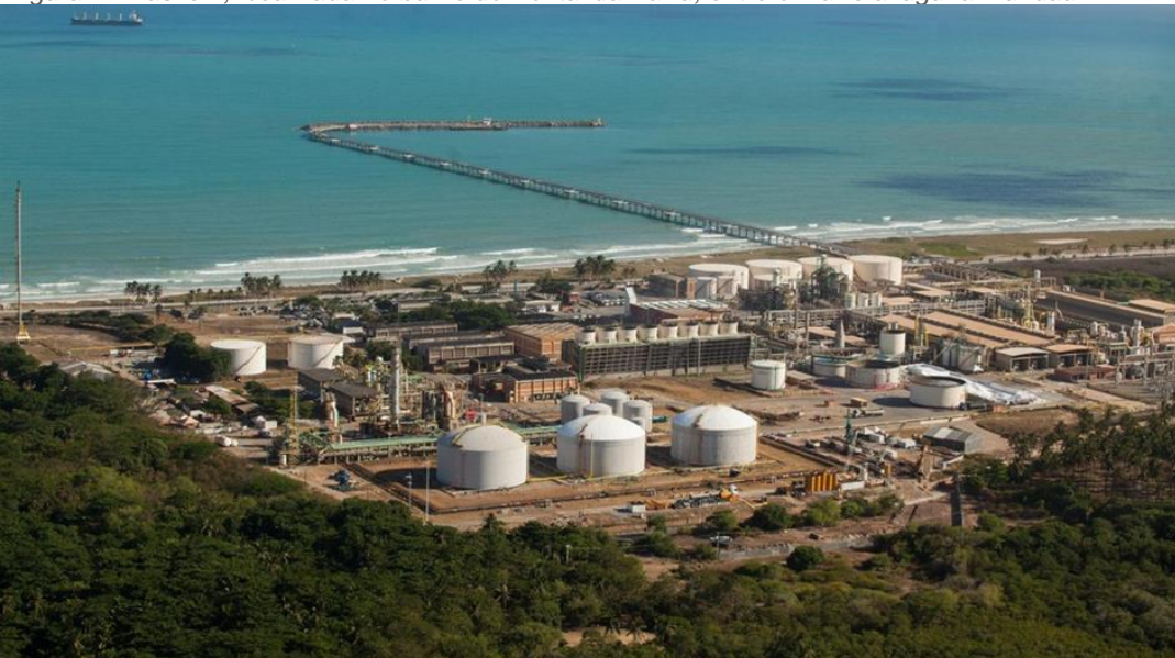
Figura 4: Braskem, localizada no bairro do Pontal da Barra, entre o mar e a laguna Mundaú.
