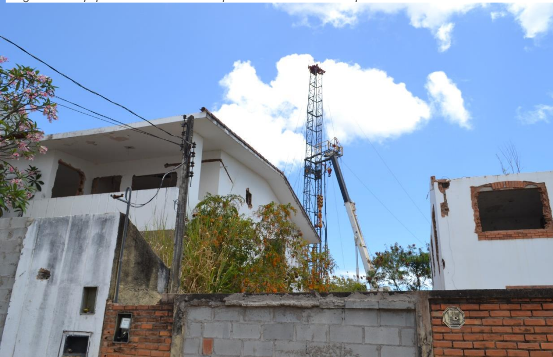
Figura 41: Equipamentos da Braskem próximo a casas desocupadas no bairro do Pinheiro.
