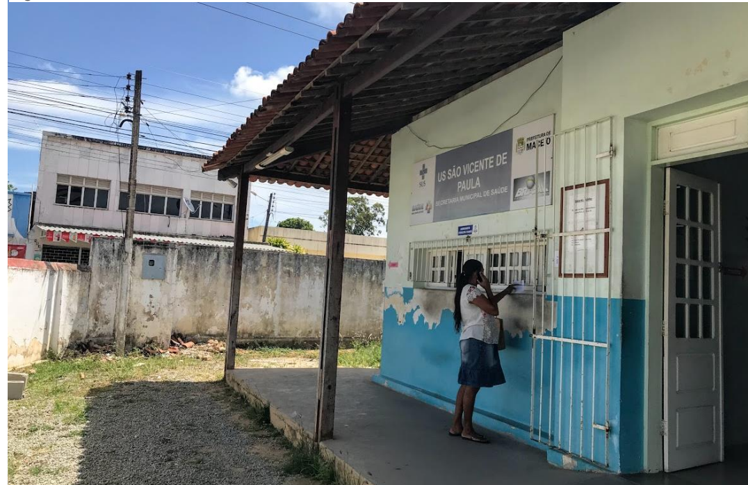
Figura 35: U.S. São Vicente de Paula no bairro do Pinheiro, antes de ser desativada.
