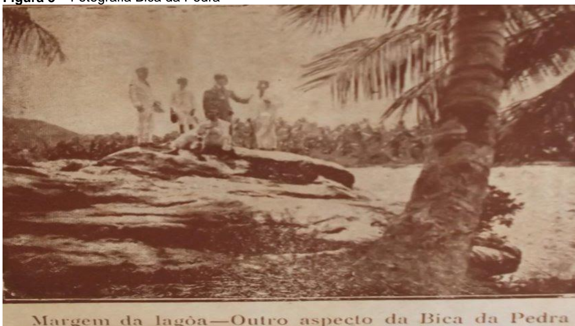
Figura 3 – Fotografia Bica da Pedra
