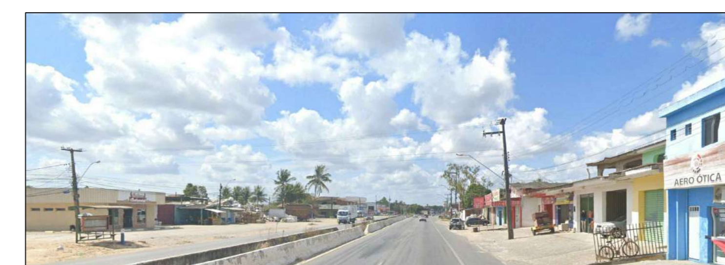
03 TRECHO 02 - VISTA DA RODOVIA NO ENTORNO DA PANIFICAÇÃO CONTINENTAL
