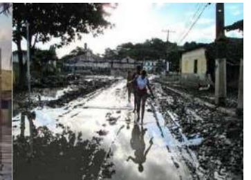
Figura 29 – Pouco restou do bairro de Gustavo Paiva. O antigo prédio da fábrica transformou-se em ruínas.
