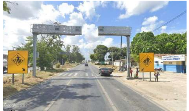
Figura 70 – Redutores eletrônicos de velocidade com sinalização vertical e faixa de pedestres em frente à Escola Estadual Santos Dumont.
