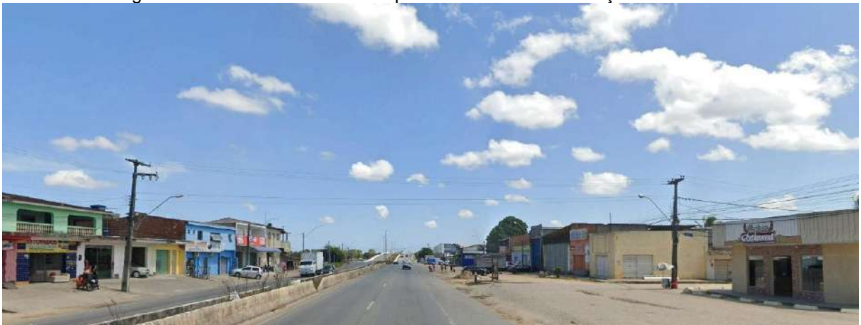
Figura 118 – Rodovia BR-104 às proximidades da Panificação Continental.
