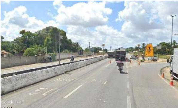
Figura 69 – Redutores eletrônicos de velocidade com sinalização vertical e horizontal nas proximidades do Residencial Jarbas Oiticica.
