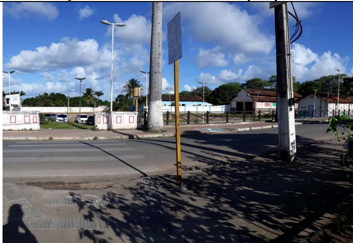
Figura 36 - Travessia na Praça Humberto Mendes – Rampas para PNE desconectadas.
