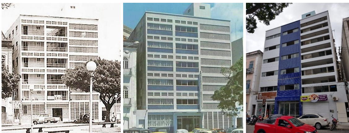
IMAGEM 45: Fachada do Edifício Parque Hotel, ao decorrer dos anos.
