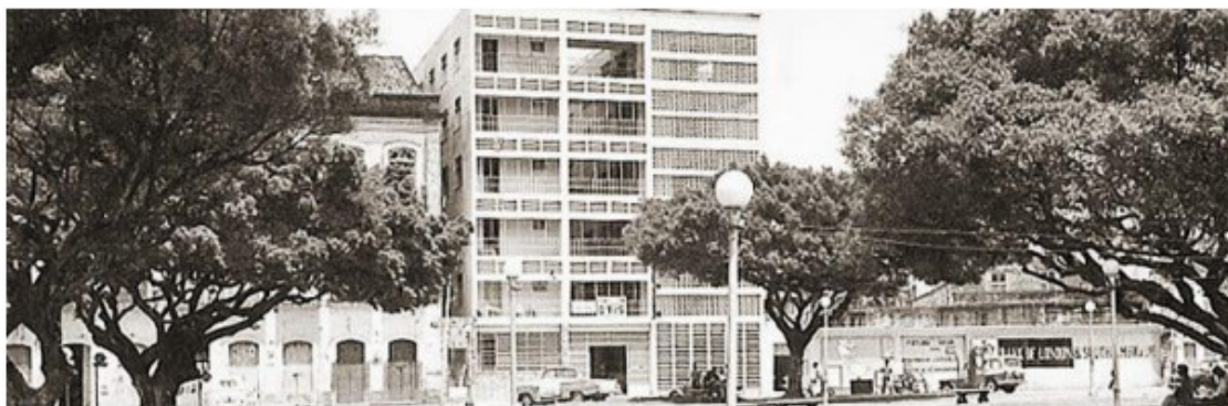
IMAGEM 43: Edifício Parque Hotel.
