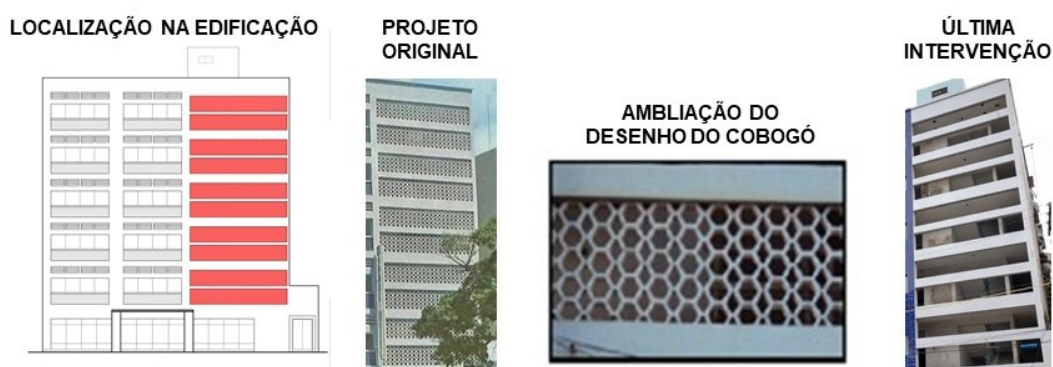
IMAGEM 50: Detalhe dos cobogós utilizados e sua remoção.
