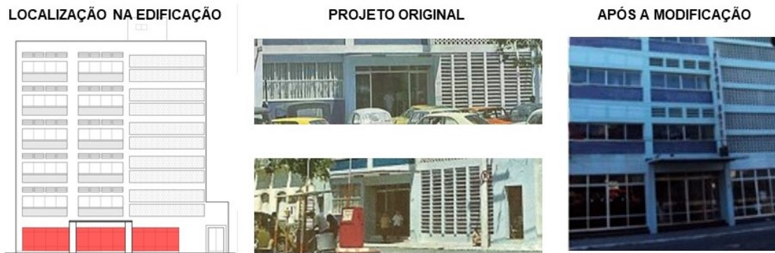
IMAGEM 46: Modificações na fachada do piso térreo ao passar dos anos.
