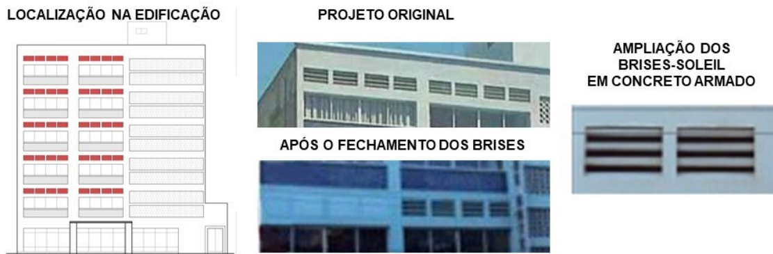
IMAGEM 47: Modificações ocorridas nos brises-soleil com o passar dos anos.
