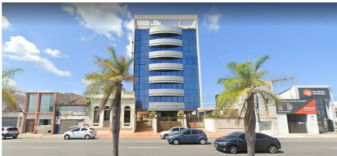
Imagem 17: Edifício Avenue Center visto de frente
