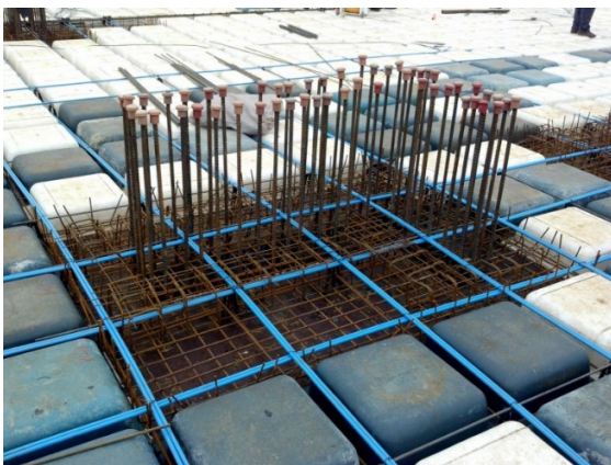
Figura 56 - Execução Laje Nervurada Protendida
