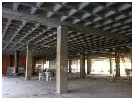
Figura 57 - Laje Nervurada executada
