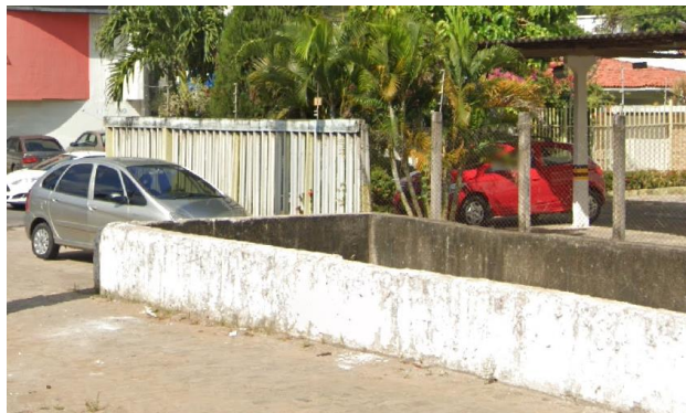
Figura 34: Passagem de seção aberta para seção fechada no ponto de alagamento 2 do canal.
