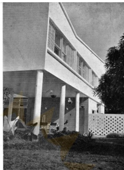
Fachada posterior. Os quartos no andar superior formam o pátio coberto no jardim. O muro furado divide a parte de serviço e social.
