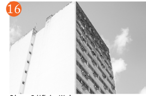
16 Obra: Edifício Walmap Data: 1965 Arquiteto: Israel Barros Correia Endereço: Rua do livramento, 148, Centro Grau de proteção: Nenhum Fotografia: Tamires Cassella, 2017.
