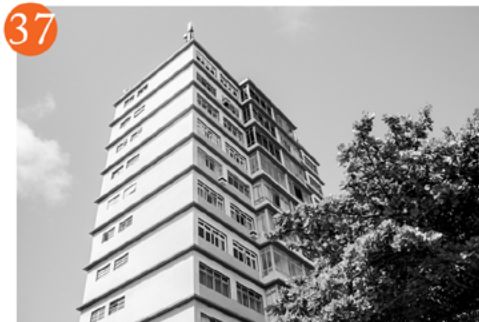
37 Obra: Edifício São Carlos Data: 1960 Desenhista: Walter de Azevedo Cunha Endereço: Av. da Paz, 1746, Centro.. Grau de proteção: Nenhum Fotografia: Tamires Cassella, 2017
