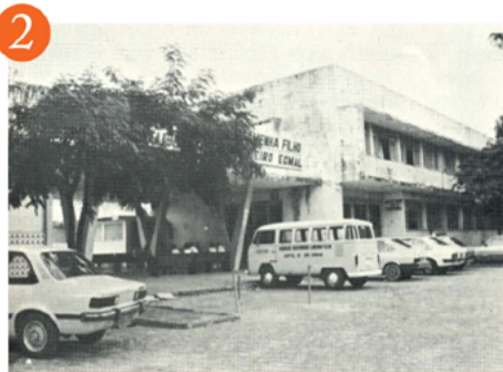
2 Obra: Hospital José Carneiro Data: 1964 Arquiteto: Joffre Saint'Yves Simon Endereço: Av. Siqueira Campos, Trapiche Grau de proteção: Nenhum Fotografia: Alberto Mofati, sem data.
