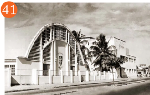
41 Obra: Ginásio do Clube Fênix Data: 1954 Arquiteto: Desconhecido Endereço: Av. da Paz, 21, Centro Grau de proteção: Nenhum Fotografia: Autor desconhecido, década de 1960.
