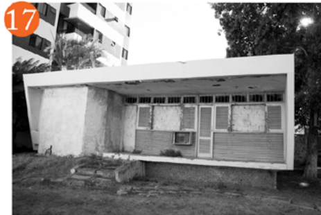
17 Obra: Residência da arquiteta ( PARCIALMENTE DEMOLIDA ) Data: 1960 Arquiteto: Zélia Maia Nobre Endereço: R. Manoel Maia Nobre, 178, Farol Grau de proteção: Nenhum Fotografia: Tamires Cassella, 2017.
