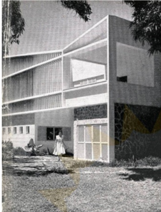
Fachada principal. Beiral, porta de treliça da garagem e brise-soleil em amarelo, vigas e tijos em branco, sendo o peitoril de alvenaria em azul.
