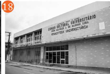
18 Obra: Reitoria da UFAL Data: 1961 Arquiteto: Zélia Maia Nobre Endereço: R. Marechal Roberto Ferreira, Praça Sinimbu, Centro. Grau de proteção: UEP Fotografia: Tamires Cassella, 2017.
