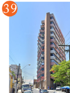
39 Obra: Edifício Delmiro Gouveia Data: Final da década de 1970 Arquiteto: Desconhecido Endereço: R. Dr. Luís Pontes de Miranda, 36, Centro. Grau de proteção: Nenhum Fotografia: Google Maps, 2019.
