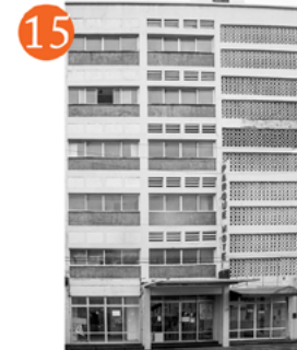
15 Obra: Parque Hotel Data: 1957 Arquiteto: Zélia Maia Nobre Endereço: Ladeira Manoel Ramalho de Azevedo, 38, Farol Grau de proteção: Nenhum Fotografia: Tamires Cassella, 2017.
