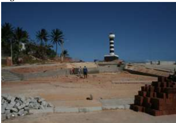
Figuras 52 - Obras no farol do Pontal
