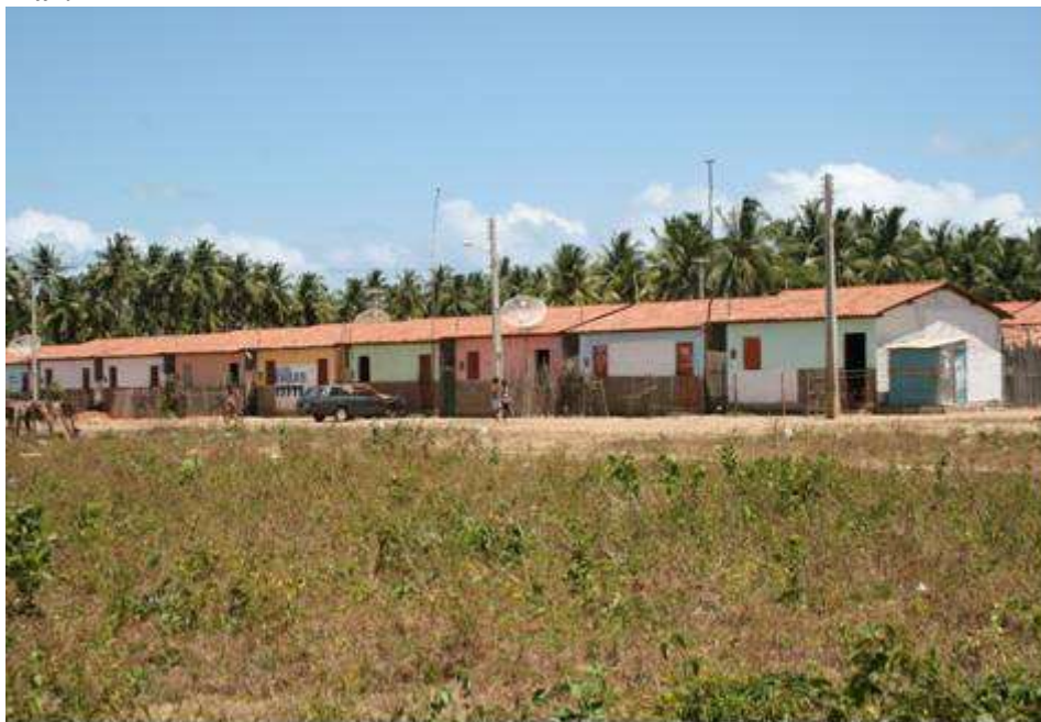
Figura 45 - Conjunto Novo, mais conhecido pelos moradores do Pontal como “Quilombo”. Habitações construídas para as famílias que perderam suas casas e que moravam próximas ao mar.
