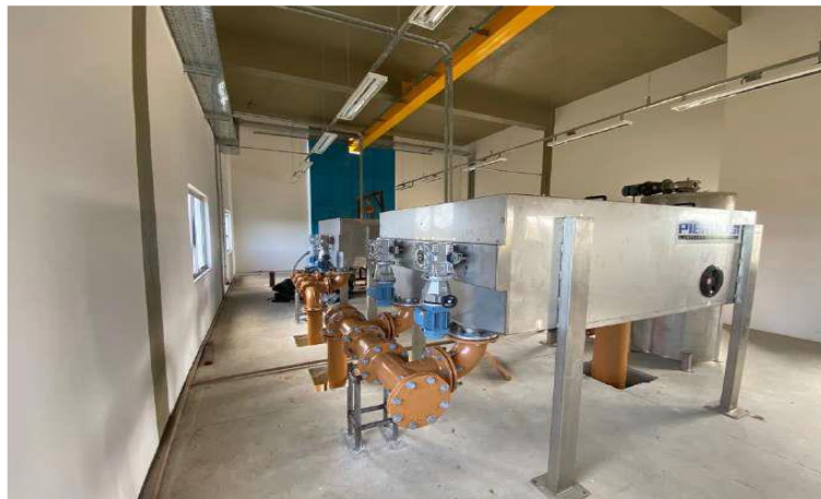
Figura 22 - Adensadores mecânicos.
