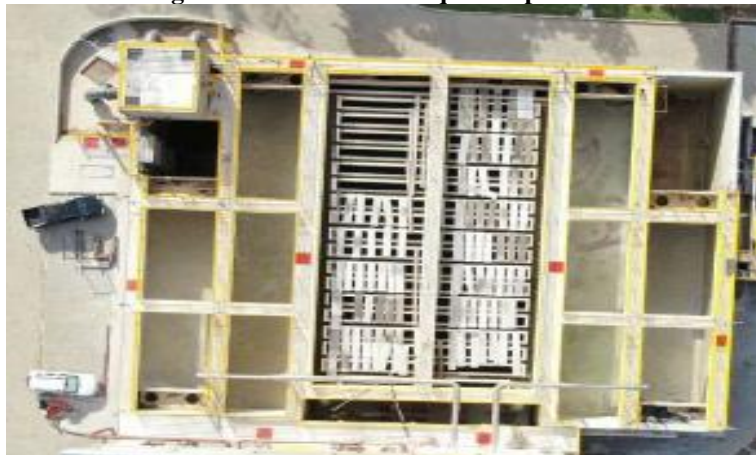
Figura 11 - Visão dos tanques de processo
