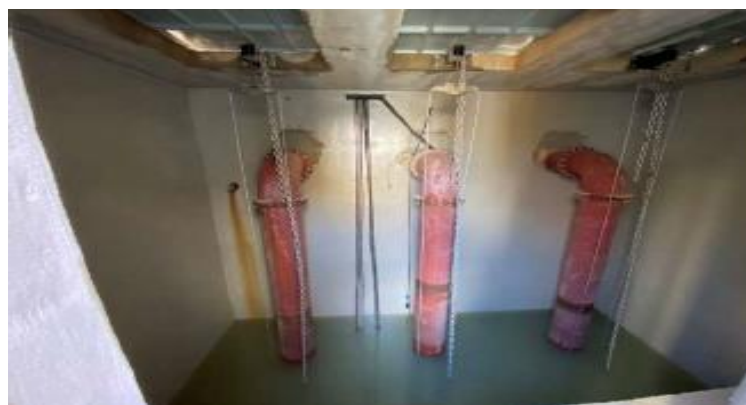
Figura 16 - Bombas submersíveis
