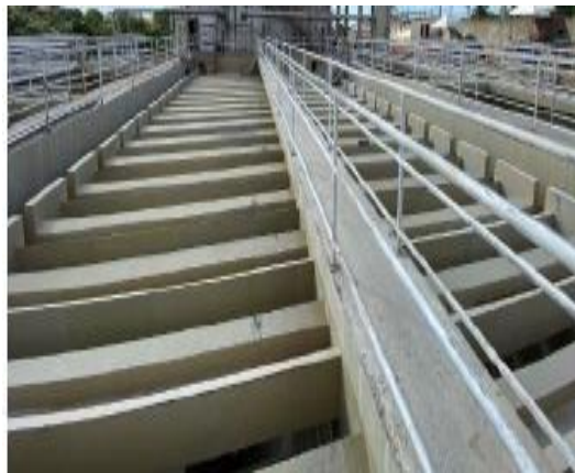
Figura 20 - Decantador Lamelar
