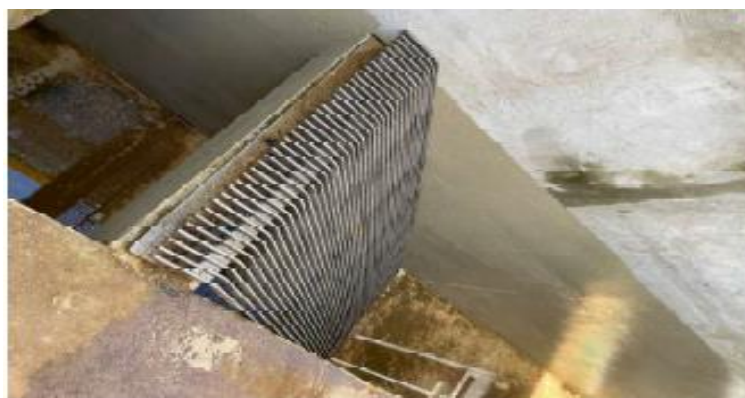
Figura 15 - Gradeamento da EEE.
