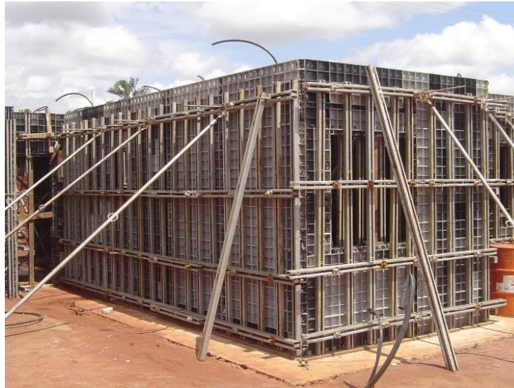
Figura 6 - Sistema de fôrmas metálicas
