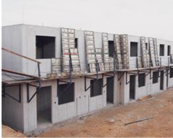
Figura 2 - Paredes de concreto armado após concretagem e desfôrma
