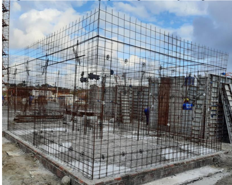
Figura 15 - Telas com espaçadores para armação de parede
