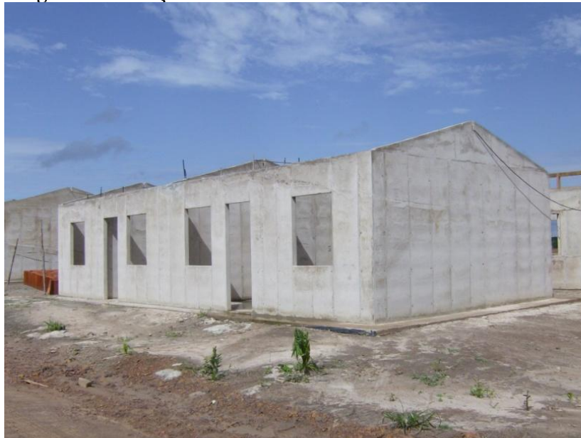
Figura 1 - Vedação e estrutura constituindo o mesmo elemento
