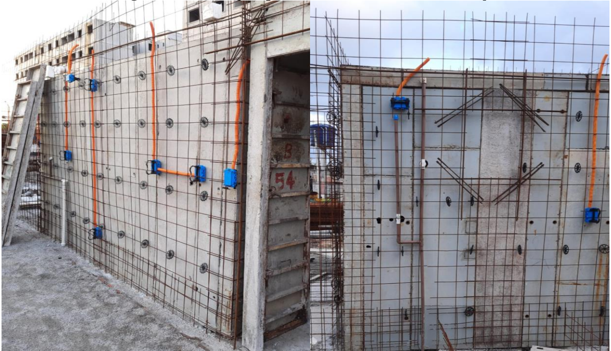
Figura 16 - Instalações prediais fixadas nas telas de armação
