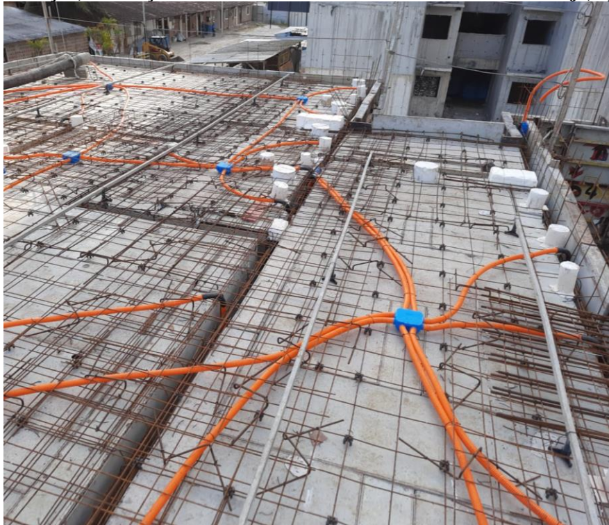
Figura 19 - Armação, instalações hidrossanitárias e elétricas executadas em laje, após inspeção.
