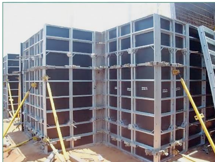
Figura 7 - Fôrmas metálicas + Compensado
