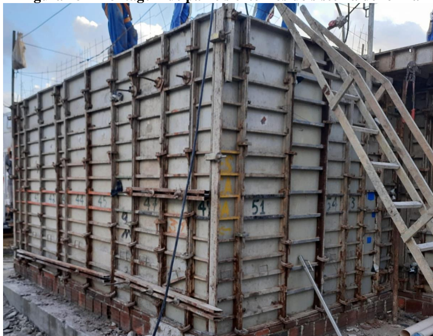
Figura 18 - Montagem de painéis externos do sistema de fôrma
