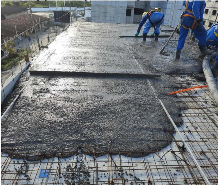
Figura 20 - Inspeção dos serviços durante a etapa de lançamento do concreto
