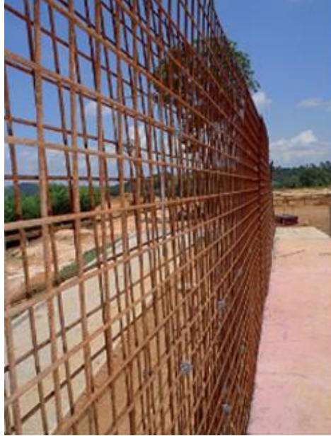
Figura 3 - Telas de aço eletrossoldadas
