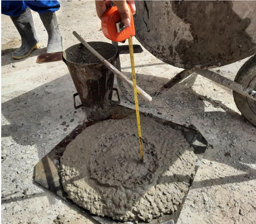
Figura 21 - Execução do Slump Test para controle tecnológico e lançamento do concreto
