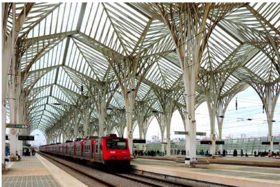
Figura 8 – Estrutura metálica reticulada compondo a cobertura da Gare do Oriente, em Lisboa, Portugal, projeto do arquiteto e engenheiro espanhol Santiago Calatrava.
