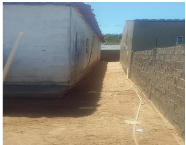
Figura 4 - Laterais da creche
