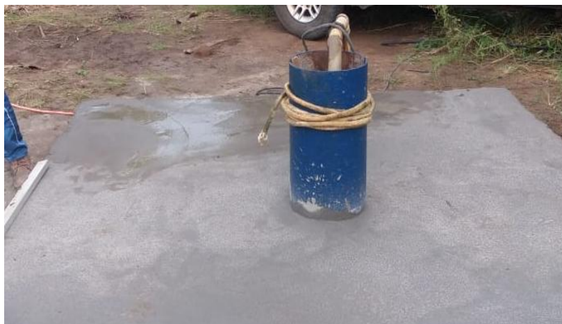
Figura 03 - Construção de poço semi artesiano
